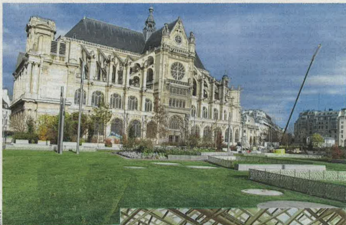
Chantier des Halles (1 er ), hier. L'église Sainte-Eustache semble dominer une prairie. Les jardiniers y ont planté des graminées et des plantes vivaces. La canopée (ci-contre) se présente comme un système d'« écaïlles translucides ».
